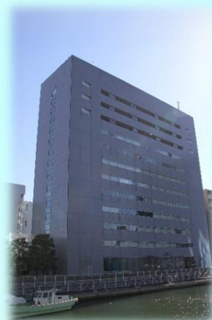
本社オフィスは東京・浜松町 のウォーターフロント
